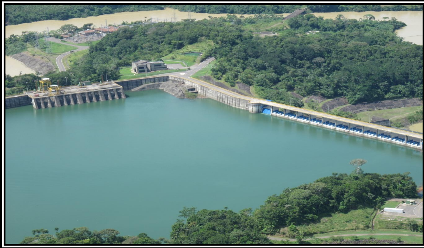
CENTRAL HIDROELÉCTRICA URRÁ I
